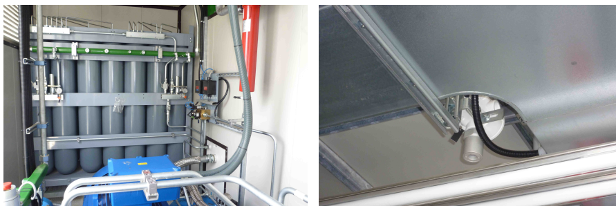
Figura 5. Botellas de almacenamiento. Detector de gas.
