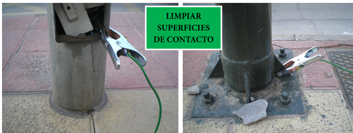
Figura 3. Elementos aptos como medio para la puesta a tierra (alumbrado-izquierda; semáforo-derecha).
