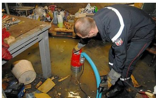
Figura 6. Achique mediante electrobomba.
