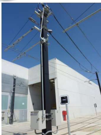
Figura 11. Vista general seccionador
