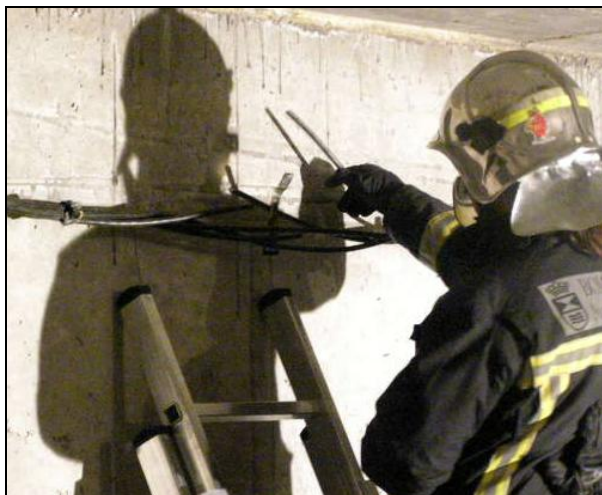
Figura 8. Detalle de separación de cables de trenzado
