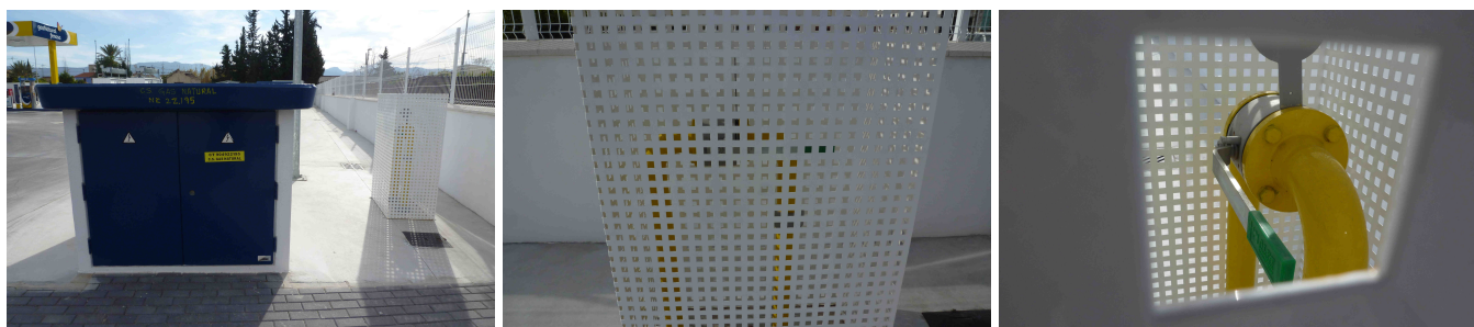
Figura 1. Detalle del entronque y acometida a la gasolinera. Válvula principal de entrada.
