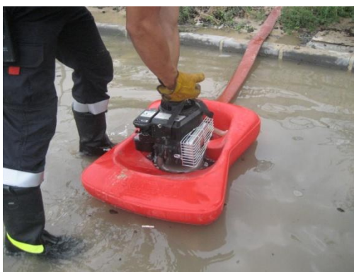
Figura 4. Achique mediante motobomba flotante en aparcamiento E-leclerc.
