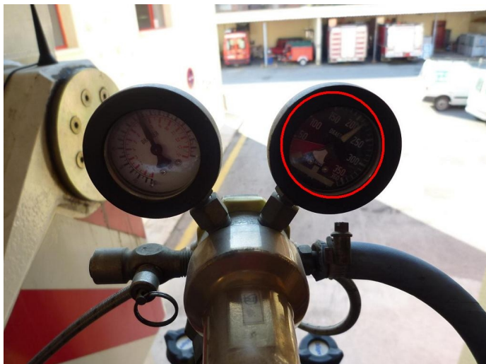
Figuras 4 y 5.- Manómetro de alta presión (botella) y detalle de la válvula de purga.
