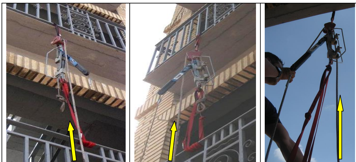
Figuras 2, 3 y 4. Se observa la fijación del torno por ambos extremos para poder trabajar con él en posición vertical.
