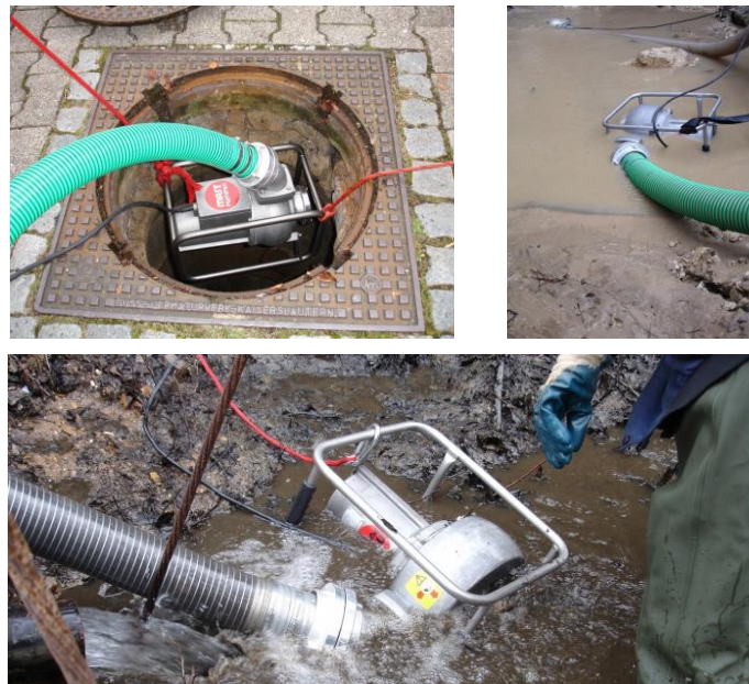
Figura 3. Bomba MAST PUMPEN ATP 10R trabajando en el achique de aguas sucias.
