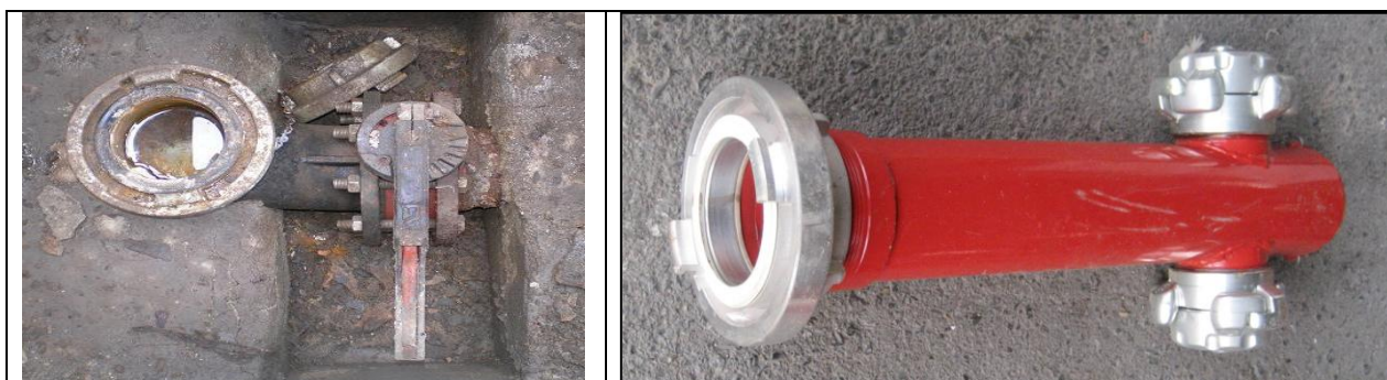
(Figura 5, izquierda). Detalle de hidrante subterráneo con toma de \varnothing 100 mm tipo storz. Figura 6, derecha). Columna hidrante, para repostado en hidrantes subterráneo del modelo de la izquierda, poseen entrada de 100 mm storz y dos salidas de 70 mm tipo Barcelona.
