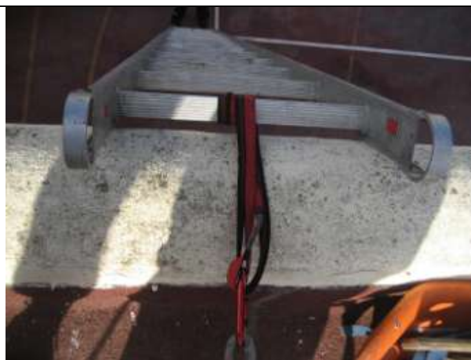
Figuras 4 y 5. Sujeción de la parte alta de la escalera.
