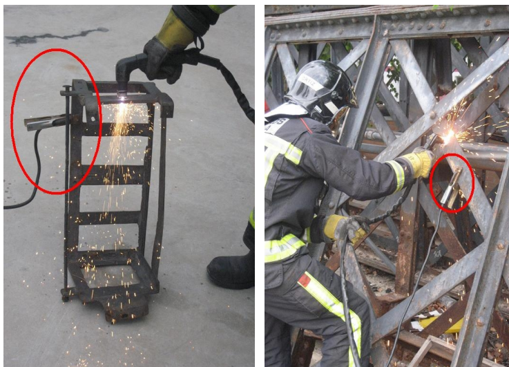
Figuras 4 y 5.- Detalles de la colocación de la pinza de masa.
