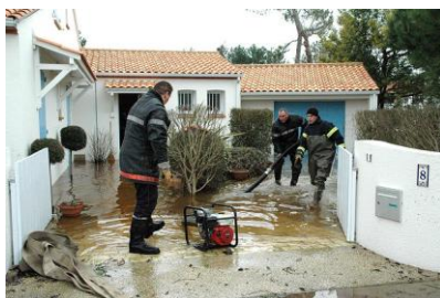
Figura 3. Achique mediante motobomba.
