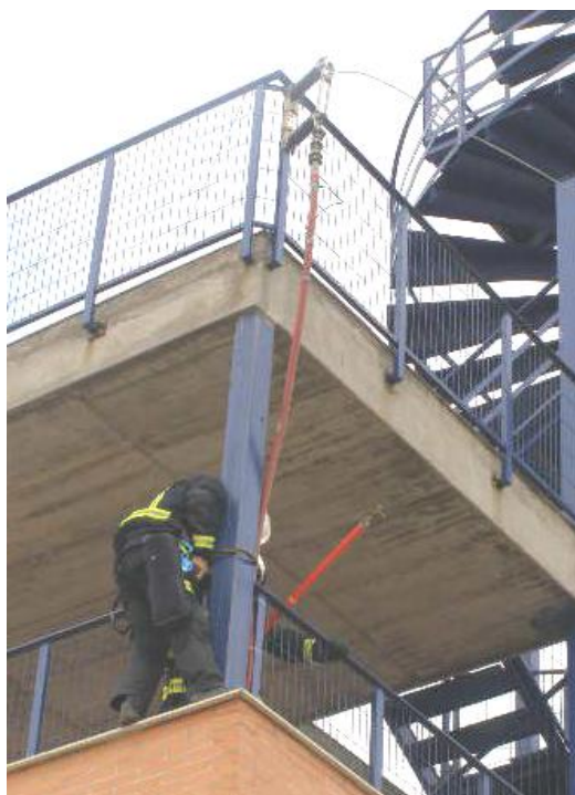
Figuras 14 y 15. Proceso de apertura de cuchillas (seccionadores), para corte de suministro, en una instalación eléctrica.
