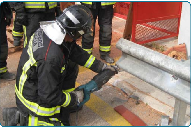
Figura 10. Corte de guardarrail.
