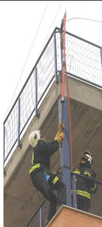
Figuras 14 y 15. Proceso de apertura de cuchillas (seccionadores), para corte de suministro, en una instalación eléctrica.
