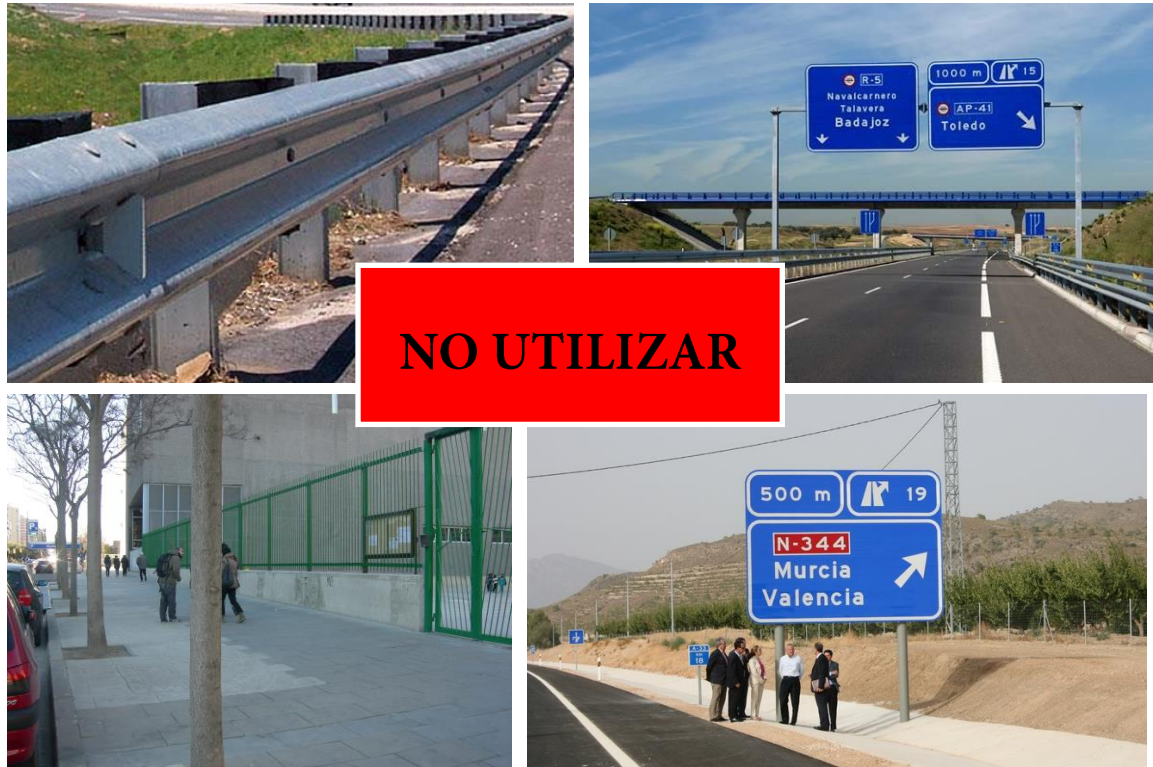
Figura 2. Elementos no aptos como medio para la puesta a tierra.
