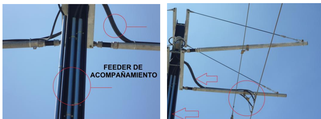
Figura 3 y 4. Subida de feeder por el poste (i) e inyección a la catenaria (d)
