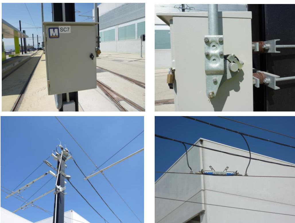
Figura 7,8,9 y10. Detalles del seccionador.
